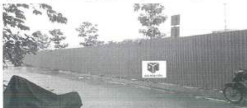
Hình 3. 20. Hình ảnh minh họa biện pháp quây tôn cách li công trường thi công với xung quanh
