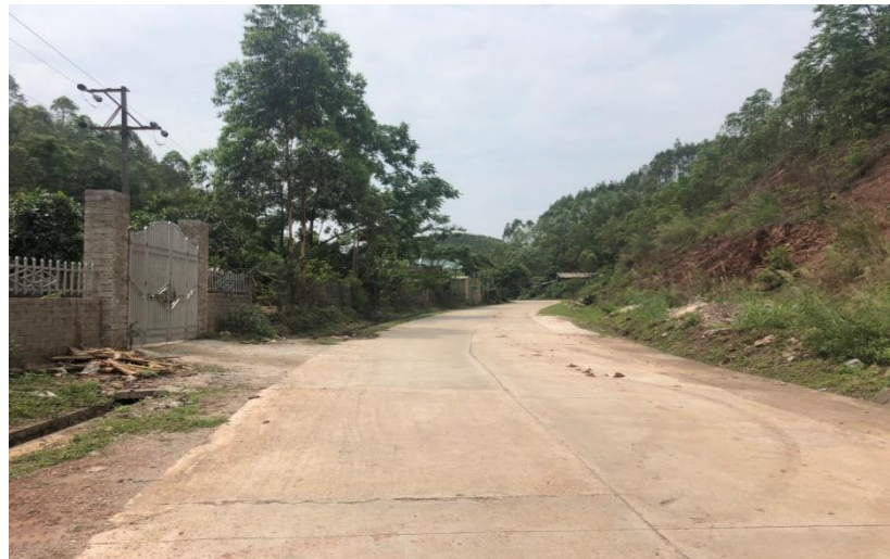
Hình 3: Hiện trạng đường giao thông
