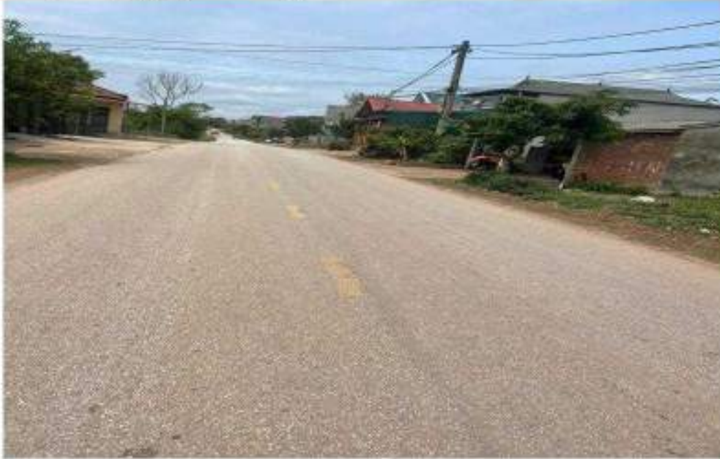
Hình 1. 4. Tỉnh lộ 248 hiện trạng
