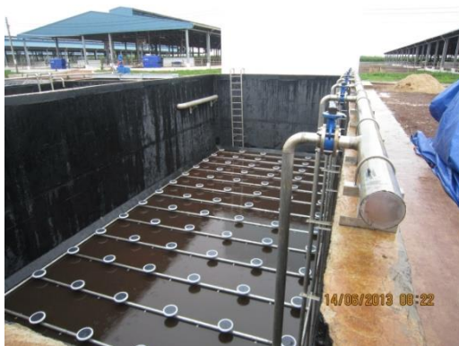
Hình 3.7. Hệ thống phân phối khí
