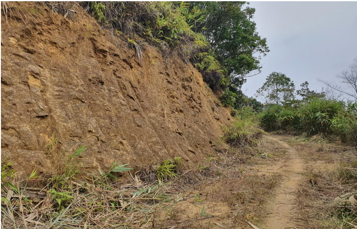
Hình 2.1. Địa hình đặc trưng khu vực tuyến M1070-M1072 và M1082-M1090
