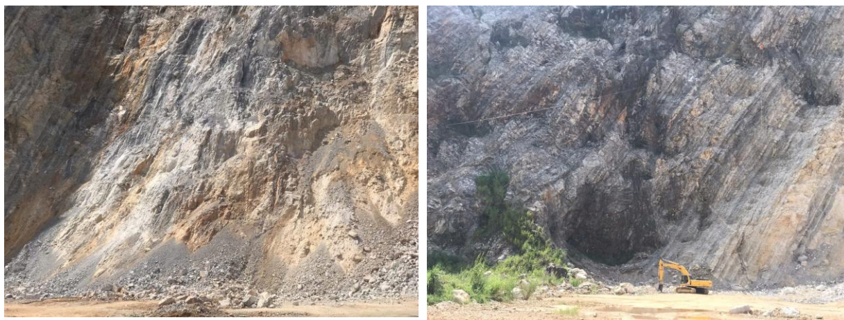
Hình 1.1: Hiện trạng khu vực khai trường của Dự án
