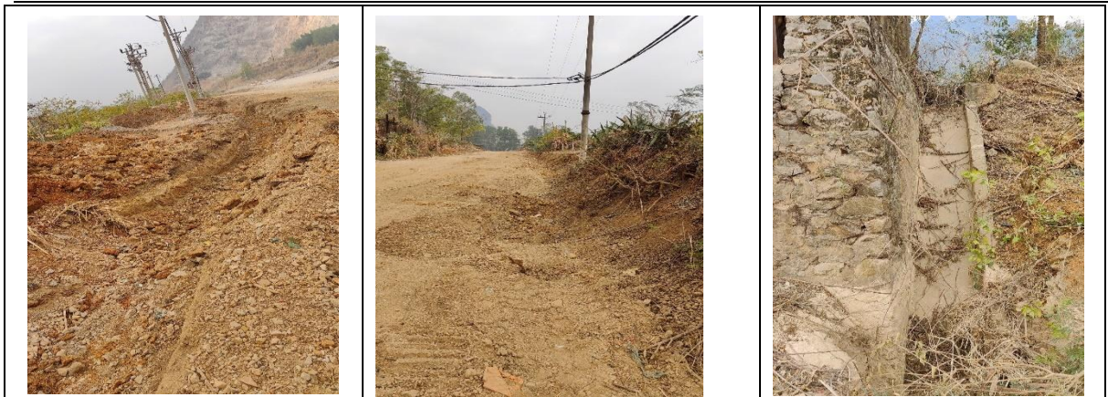
a) Rãnh đất tiêu thoát nước mưa chảy tràn khu vực khai trường
