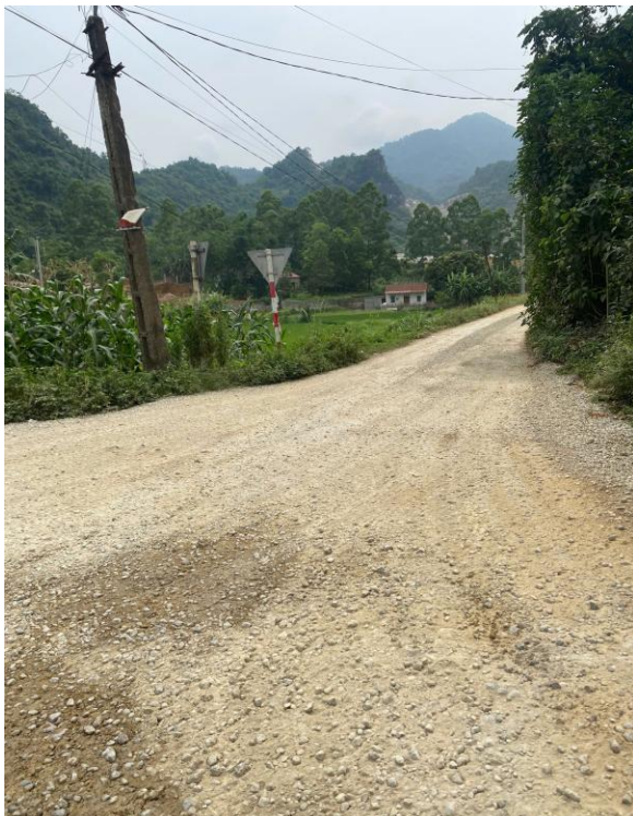
a) Hiện trạng đường vào mỏ trải đá cấp phối
