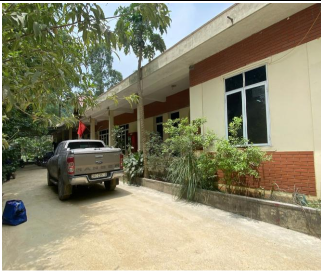
a) Khu nhà điều hành 200 m 2
