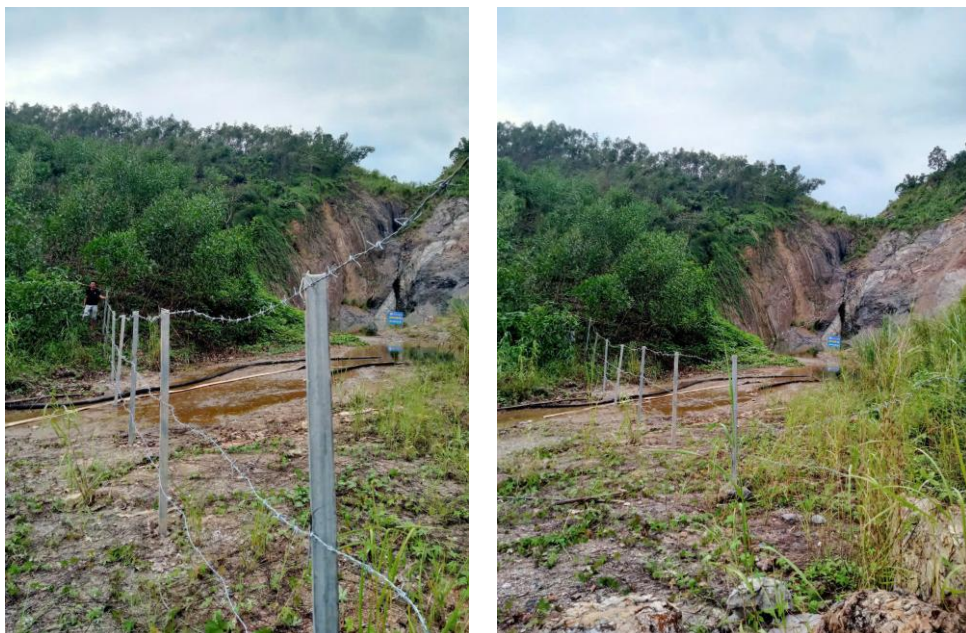
Hình 4.2: Hình ảnh thực tế thi công hạng mục rào thép gai
