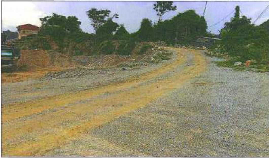
Hình 1.5. Hiện trạng tuyến đường vận chuyển nội mỏ
